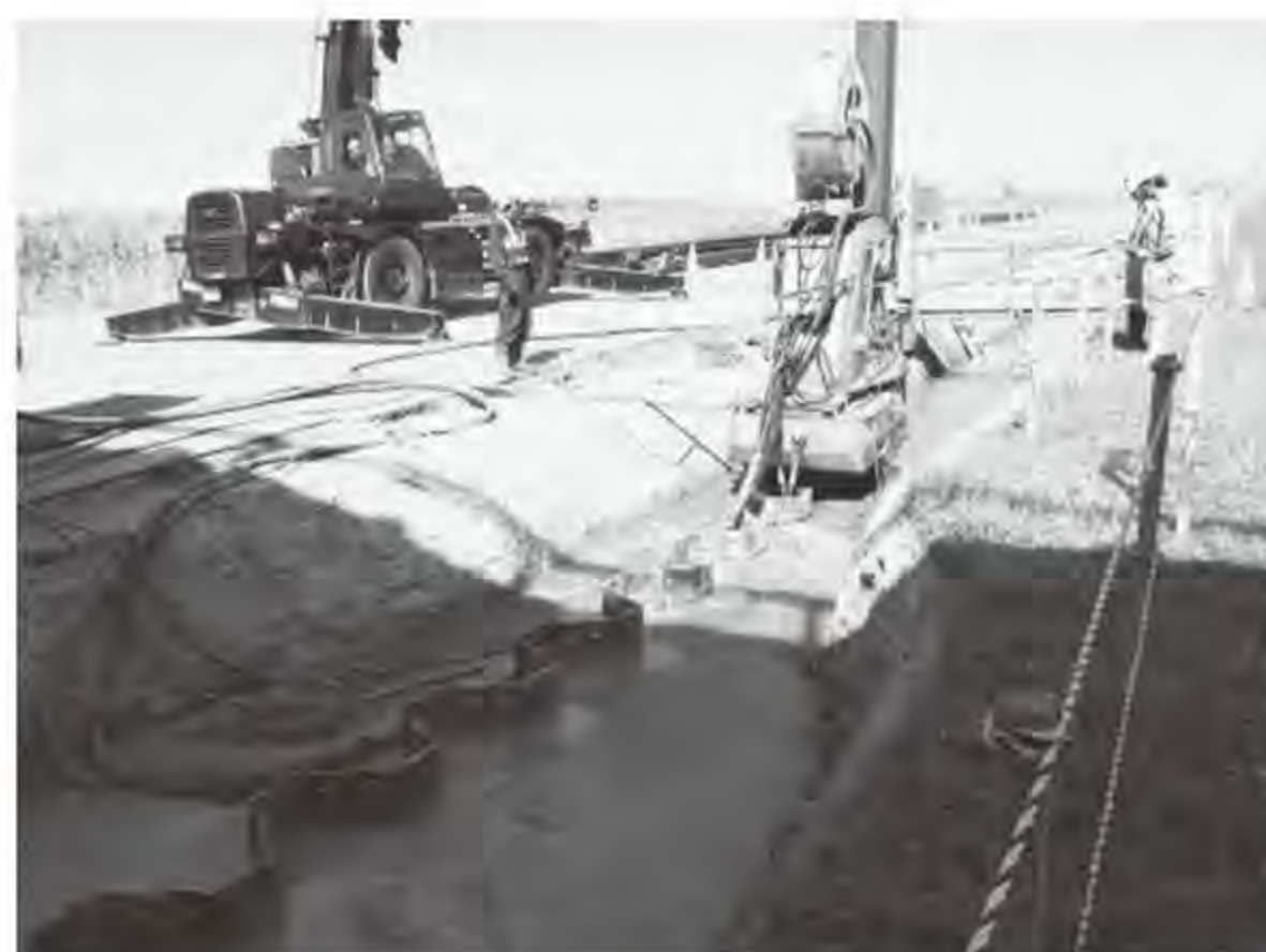
堤防耐震工事
