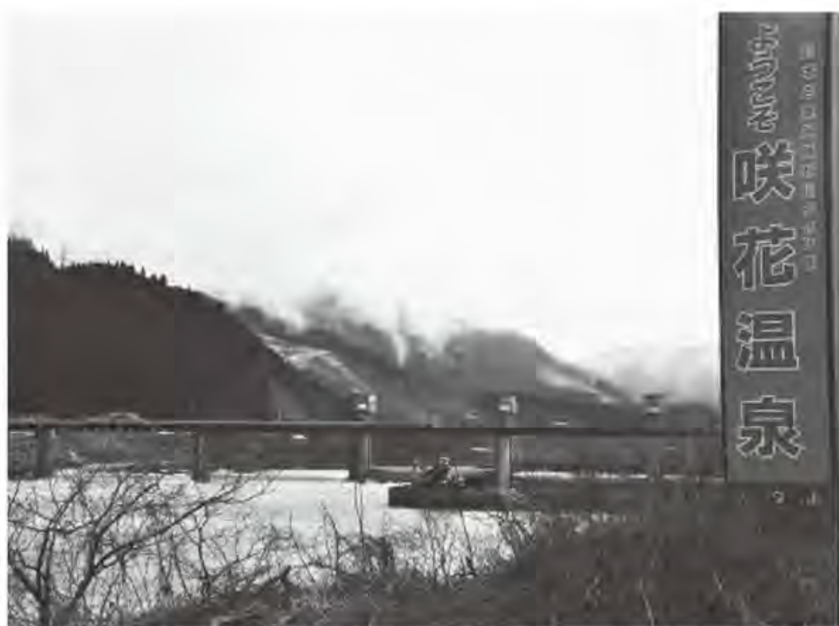
阿賀野川頭首工
