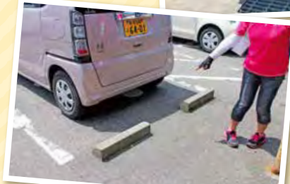
車椅子駐車場なのに車の後から車椅子が降ろせない駐車場
