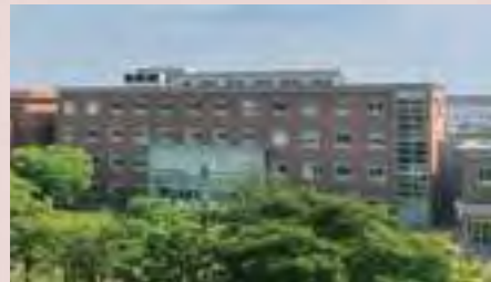
※1 2010(平成22)年竣工の1号館B棟
