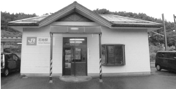
図1 プロジェクト開始前の駅の外観
