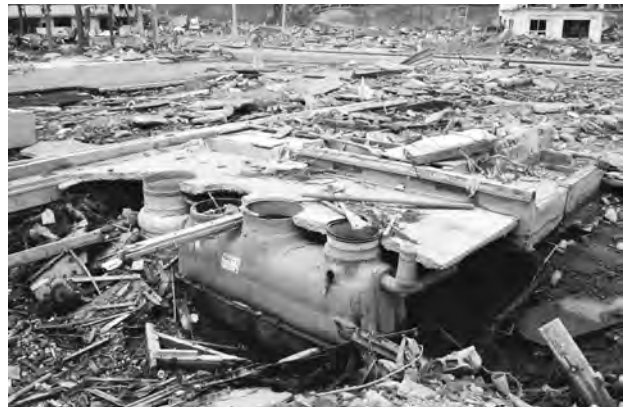
津波で町の中心部も壊滅的な被害を受けた。津波の流水作用で地盤が洗掘されている（宮城県・女川町）。
