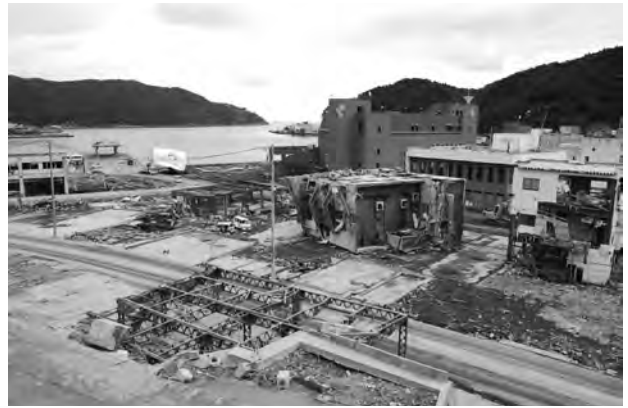
津波が室内に入り込み、押す力と空気溜まりの浮力で建物を根こそぎ剥ぎ取り、運搬・横転させている（宮城県・女川町）。
