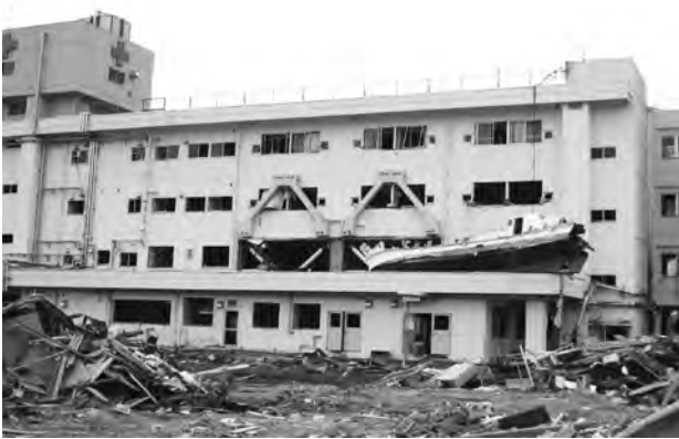
鉄筋コンクリートの病院に漂流物も押し寄せ、損傷を与えた後に、一階の屋上には船体を残している（宮城県・南三陸町）。
