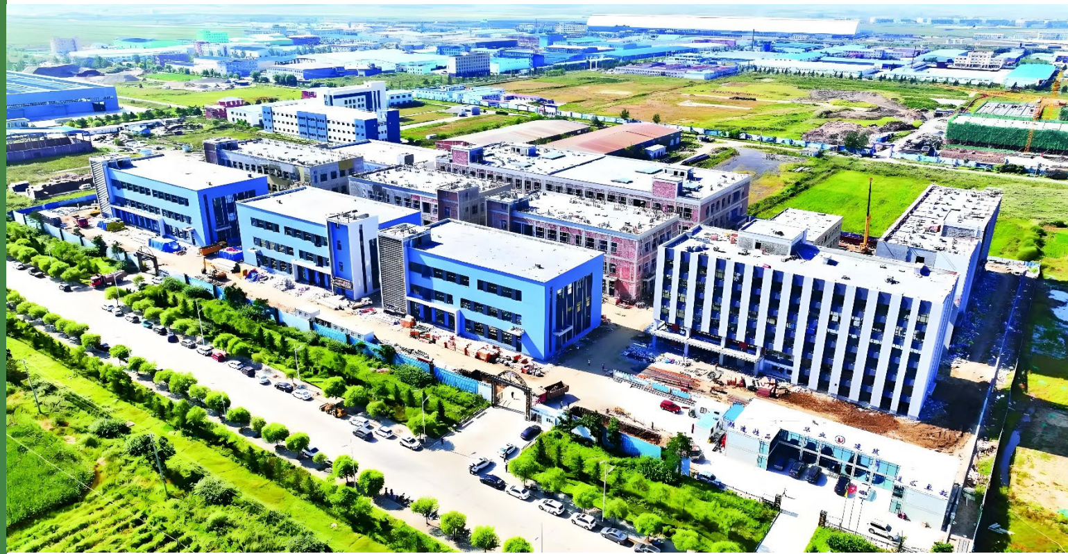
主要施設が完工
