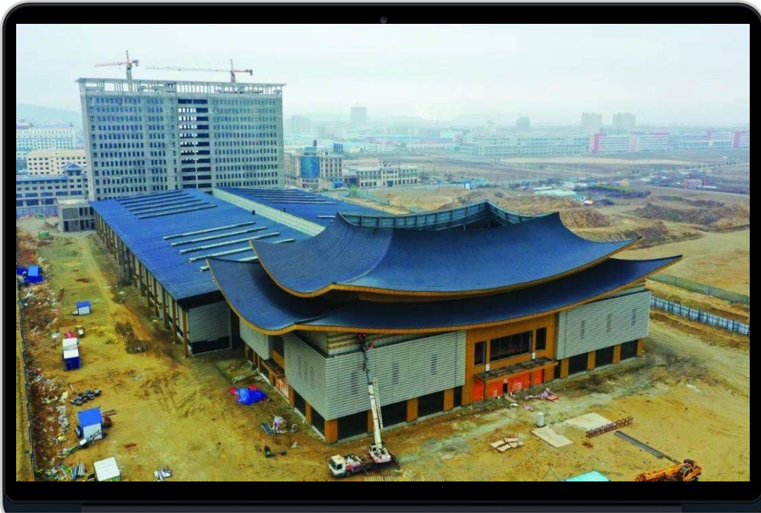
主要施設が完工
