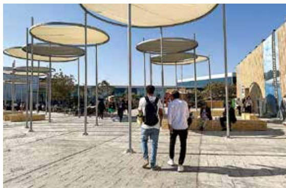
写真4 ブルーゾーンの通路
