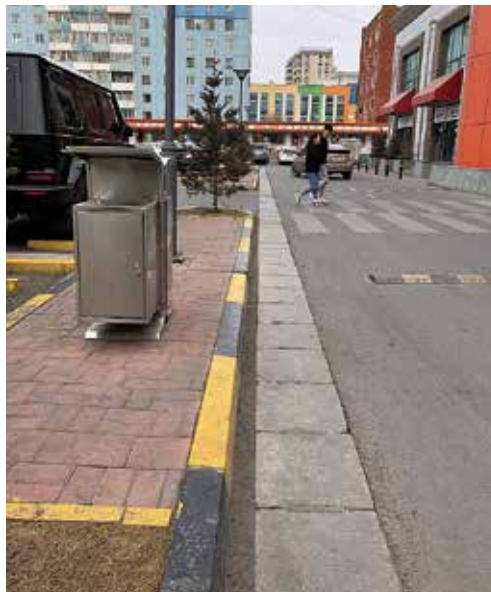
写真12 サルール食品スーパー前にある日本式道路排水溝
