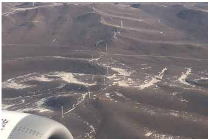
写真15 機内の窓から眺めるサルヒット風力発電所
