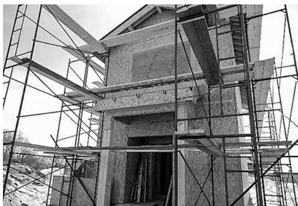
図3 カザン市郊外での住宅建設現場
