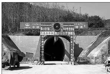
写真25 ルアンプラバン駅北側のトンネル
