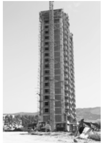
写真4 建設中の高層アパート
