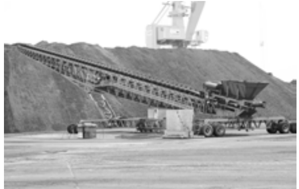
写真5 石炭を積み上げるベルトコンベア
