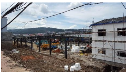
綏芬河駅の改造工事現場
