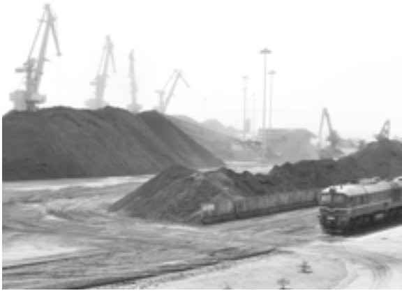
写真5 羅津港第3埠頭の荷役作業
