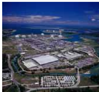
(Bontang LNG Plant)
