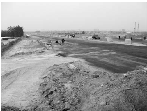
写真7 鄭州市郊外の道路建設工事現場
