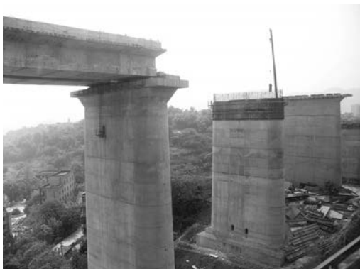
写真11 建設中の成都—重慶高速鉄道
