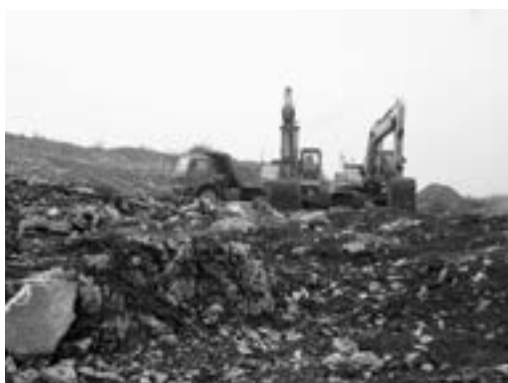
写真13 貴安新区の開発工事
