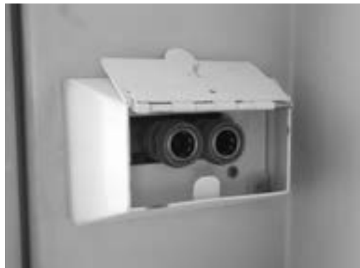
写真2 T27便列車の酸素供給口
