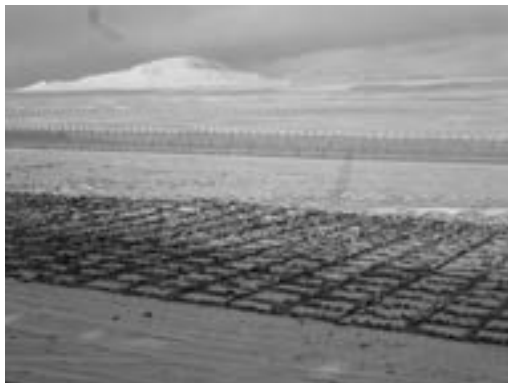
写真1 鉄道脇の土木保持・防砂工事
