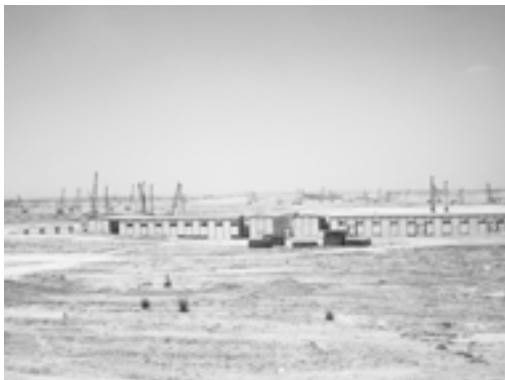
写真7 蘭州新区の建設ラッシュ
