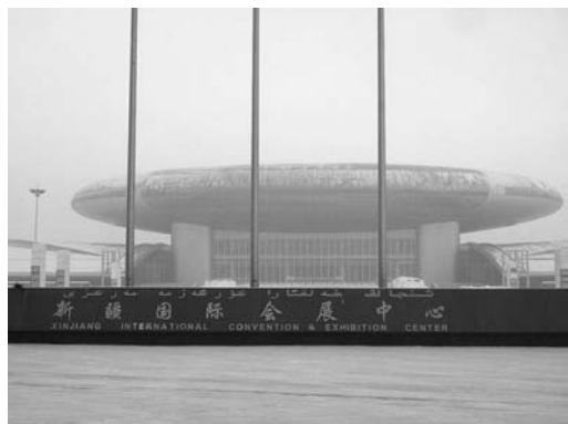
写真11 建設中の新疆国際展示センター
