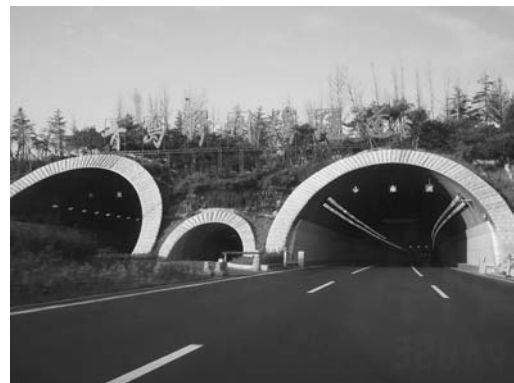
写真3 膠州湾海底トンネルの入り口
