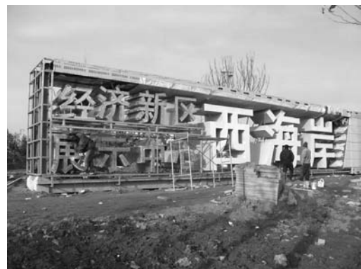
写真4 青島西海岸経済新区展示センターの玄関(工事中)
