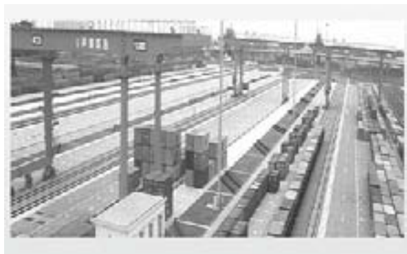
写真1 稼働するコンテナ物流センター（上海芦潮港集装箱中心駅（海港型））
