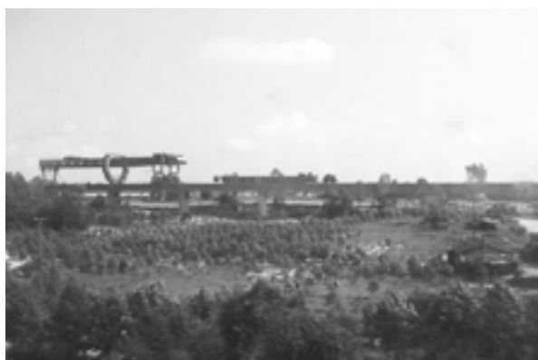
写真6 建設中の北海—南寧高速鉄道
