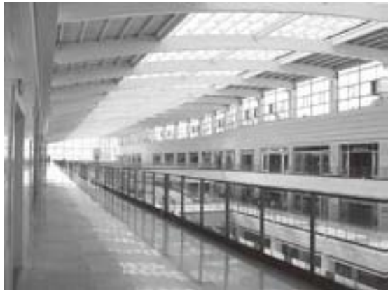
写真11 「中国ムスリム国際商貿城」の内部の様子
