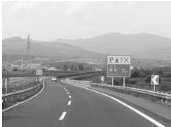
写真11 延吉～琿春区間の高速道路
