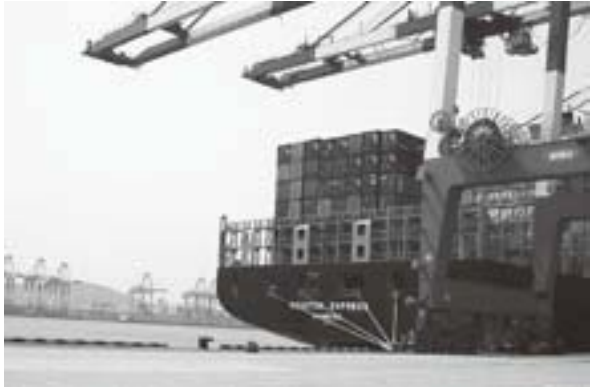
写真1 前湾コンテナターミナル
