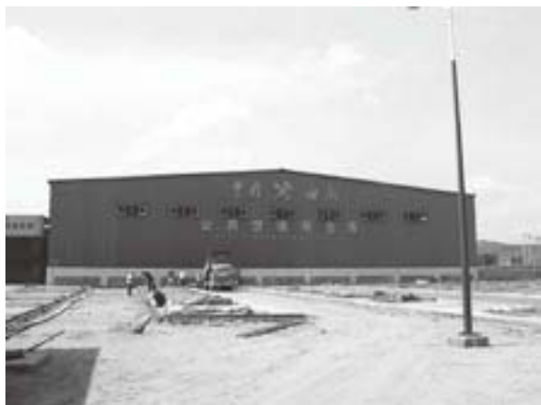
写真7 建設中の温度管理機能付き倉庫
