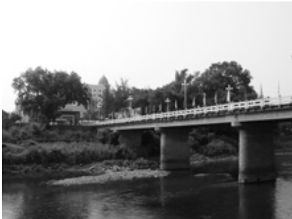
写真3 北侖河にかかる中越友誼大橋
