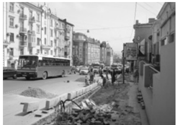
写真18 ウラジオストク市内ではあちこちで工事が
