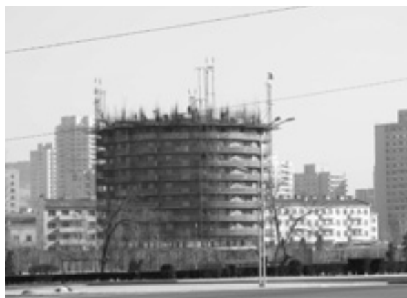
写真1 平壤市内で建設されているアパート
