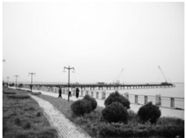
写真3 建設中の新鴨緑江大橋（丹東）
