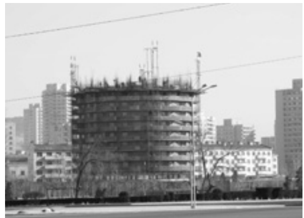
写真1 平壤市内で建設されているアパート
