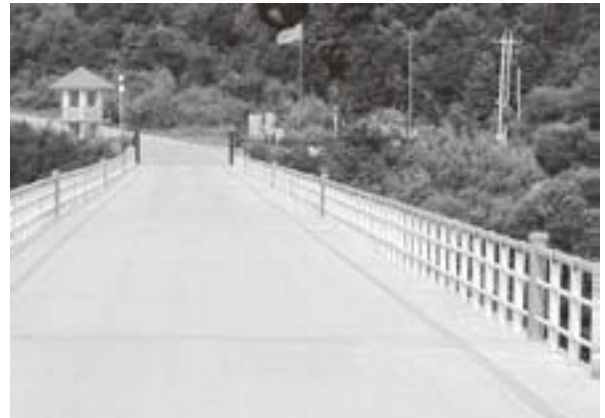
写真1 修復後の元汀橋（圈河橋）の路面
