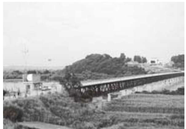
写真2 圈河橋（元汀橋）の全景
