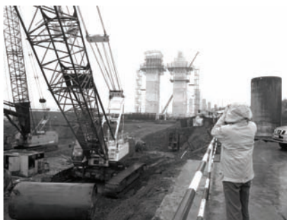
ルースキー島架橋工事現場
