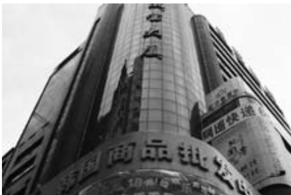
写真1 延吉市韓国製品卸センターの外観
