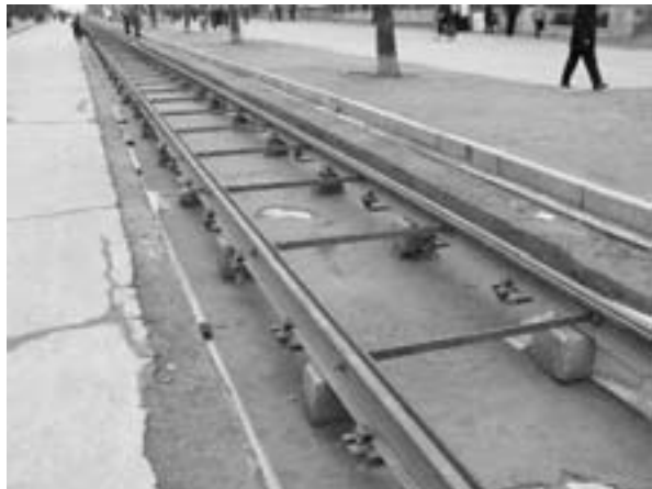
写真5 工事中の路面電車の軌道
