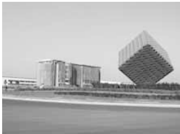
写真2 瀋陽 - 欧盟経済開発区のシンボルと建設中の工場
