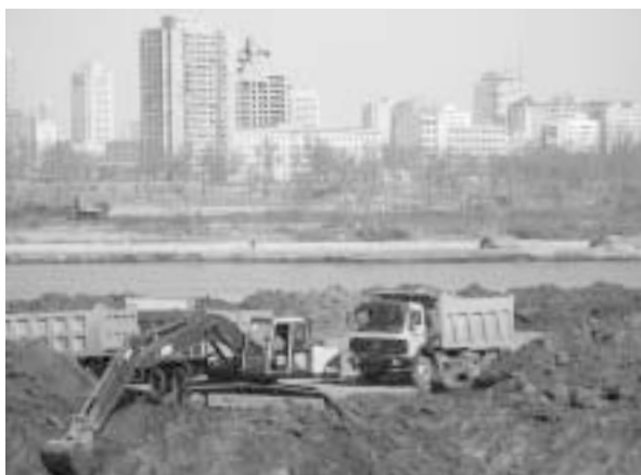
写真5 クムガン通りの建設工事現場
