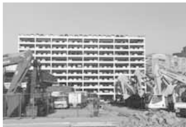
(写真1) 10階建て自動車置き場
