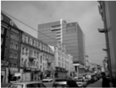
ウラジオストク市内の 新築オフィスビル
