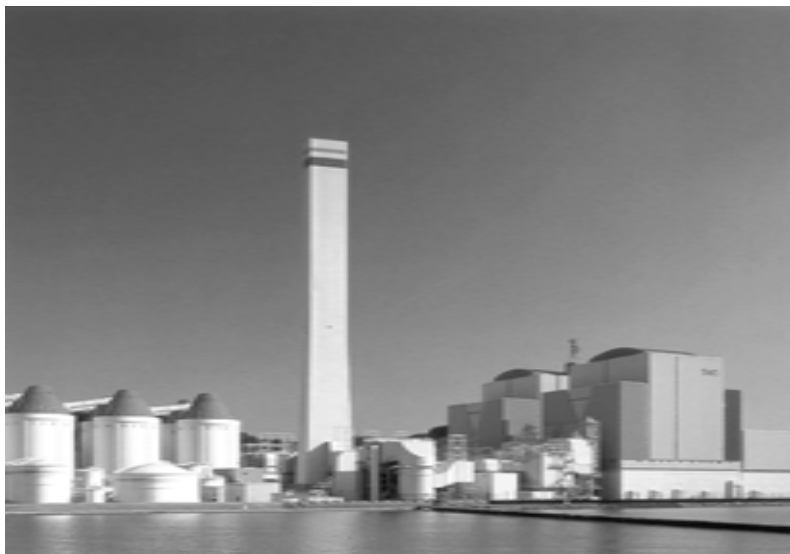
電源開発（株）橋湾石炭火力発電所（写真提供：電源開発（株））
