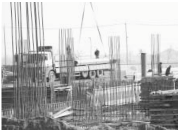
写真8 アパート型工場の新築工事現場
