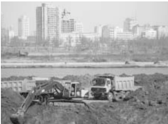
写真5 クムガン通りの建設工事現場
