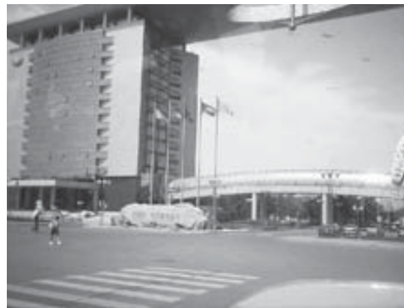
一汽本社メインエントランス
