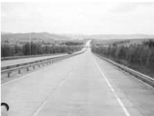
コンクリートで舗装された牡丹江～ハルビン間的高速道路
