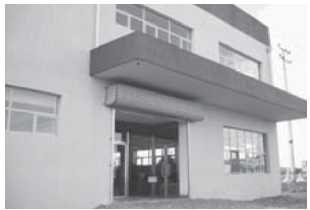
(写真1) 小島衣料琿春工場の玄関
