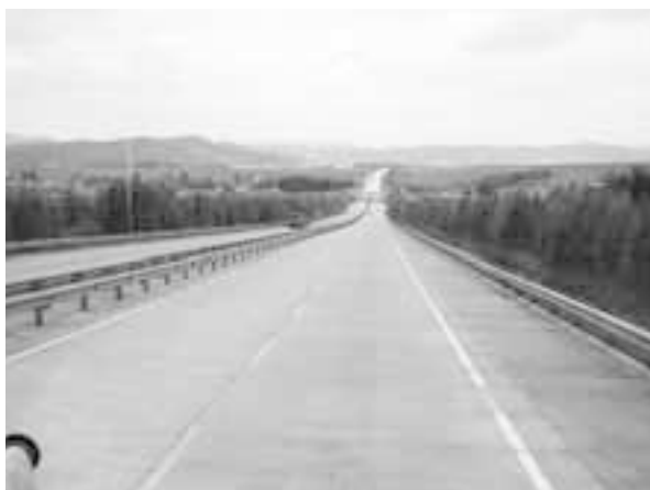
コンクリートで舗装された牡丹江～ハルビン間的高速道路
