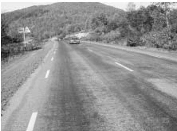
写真4 コルサコフ～ユジノサハリンスク道路 （提供：樺地域開発研究所）
