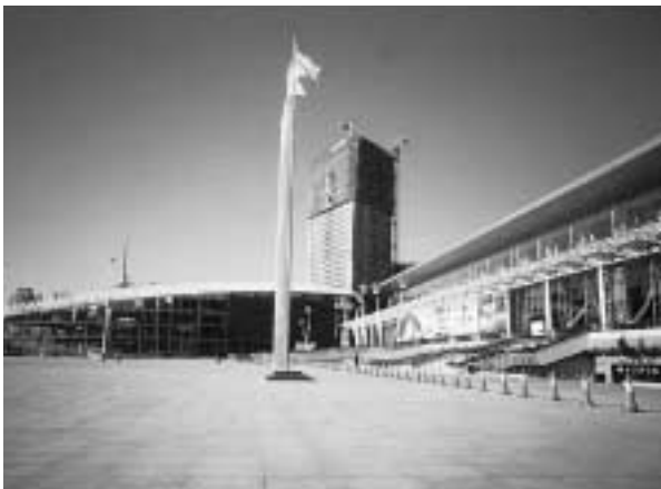
写真1 ハルビン国際展覧スポーツセンター
