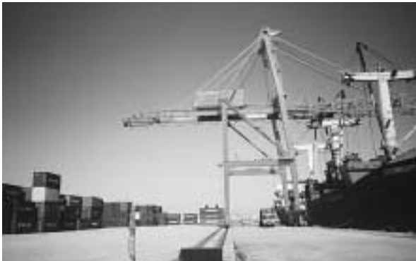
(写真3)蔚山港「オンサン港」コンテナターミナル
