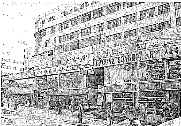
(写真-8) 青雲市場の外観
