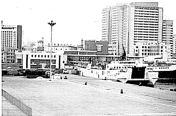
写真-4 市中心街に隣接する威海港
