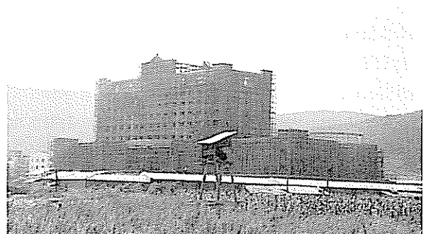
写真1 建設が進むエンペラーホテル本館
