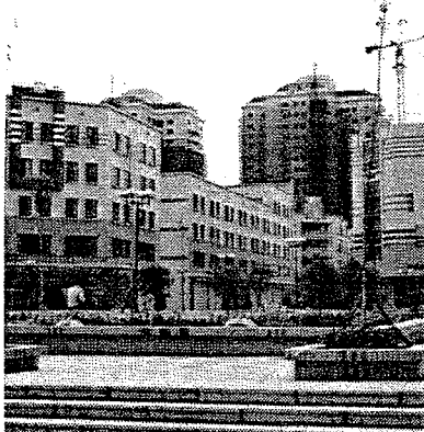
19階建ての高級マンション(昆崙商城)
